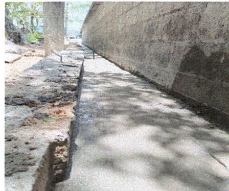
Foto 4: Fundición de la cuneta de concreto.
