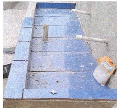
Foto 4: Lavamanos de concreto.
