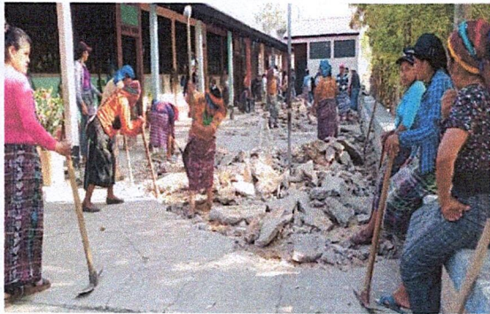
Foto 1: Demolición de la losa de patio.
