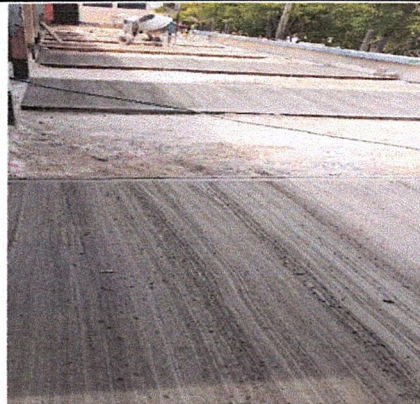
Foto 4: Fundición de losa por cuadros.
