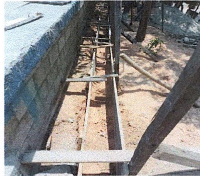
Foto 2: Parte de abajo del muro donde se realizara la cuneta de concreto.
