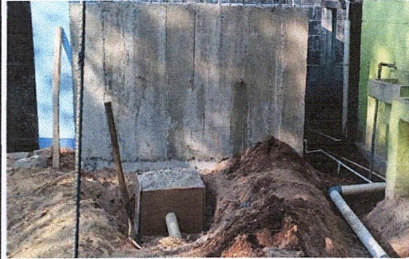
Foto 2: Reparacion e Instalacion de tuberia.
