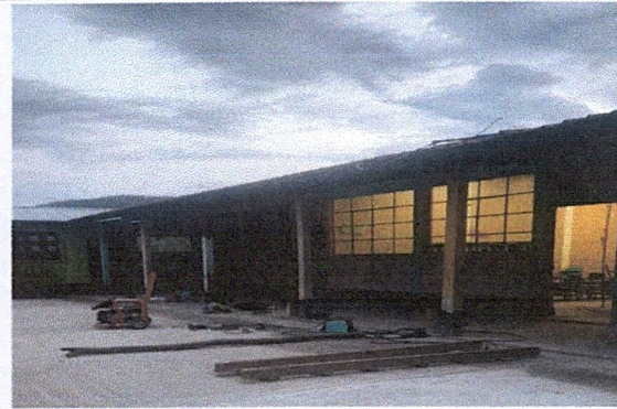
Foto 2: Instalacion de dos balcones.
