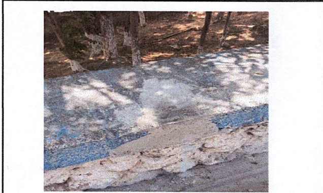
Foto 1: Reparación en partes dañadas.
