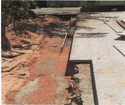
Foto 1: Lugar donde inicia la cuneta de concreto.
