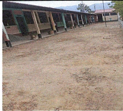
Foto 2: Nivelación del patio a fundir.
