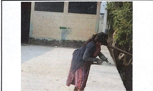
Foto 2: Quitando restos de pintura con cepillo de alambre.
