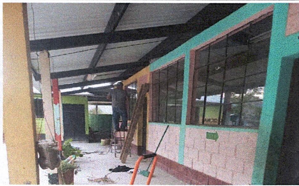
Foto 1: Inicio de la instalacion de balcones.
