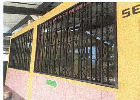
Foto 3: Balcones ya instalados
